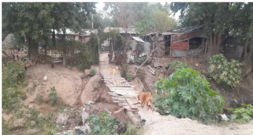
Figura 15. Casilla balconeando a zanja en Las Lomas
