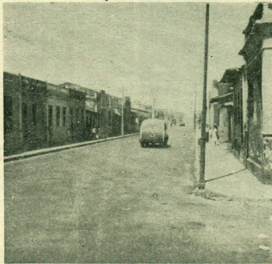
Fig. N° 3. — La calle después de la estabilización
