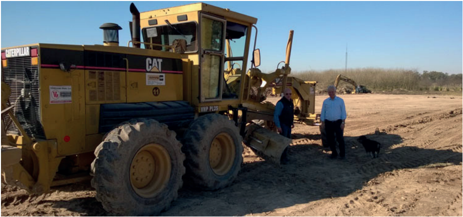
Figura 2. Obras ingenieriles en el predio cedido de la ACRC. Fuente: ACRC (2014b).
