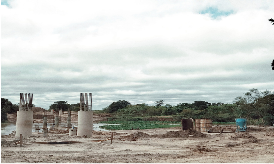
Figura 3. Construcción de nuevos puentes en áreas desmontadas, adyacentes a reservas privadas y municipales, que conectan con el Río Paraná. Fuente: fotografía propia tomada durante el trabajo de campo, Villa Ocampo, mayo 2025.
